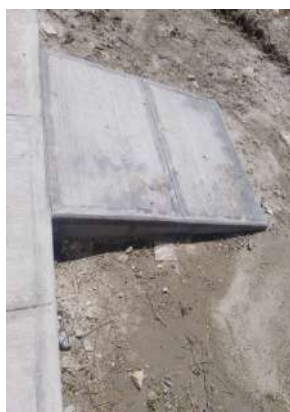
Ramplas para personas con necesidades especiales ubicadas en el primer piso justo en la salida de los laboratorios
