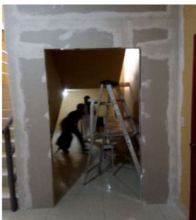
Clínica en Construcción
