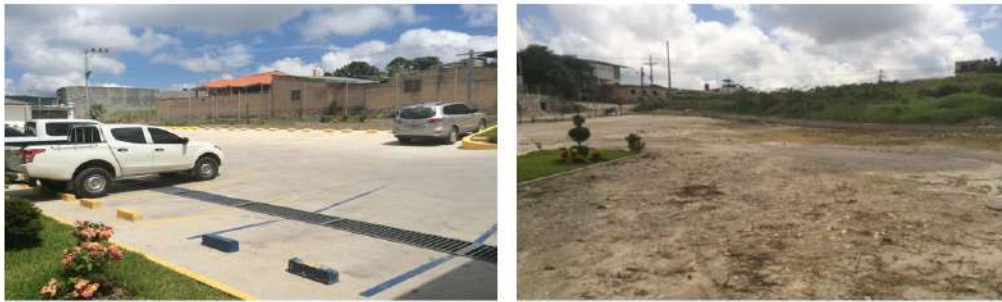
Área de Estacionamiento Actual con capacidad para 70 vehículos y área en construcción para ampliación del estacionamiento.
