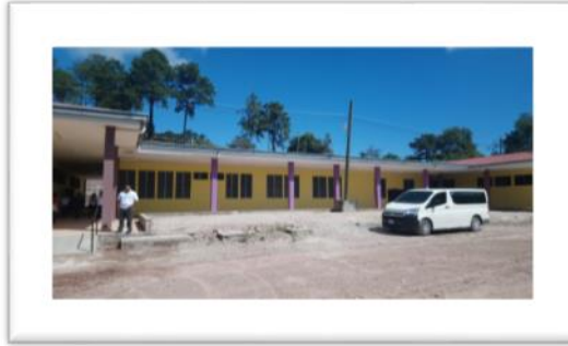
Edificio para aulas, Lab. Computación y Biblioteca
