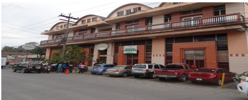
Gestión Pedagógica Fachada y parqueo del campus
