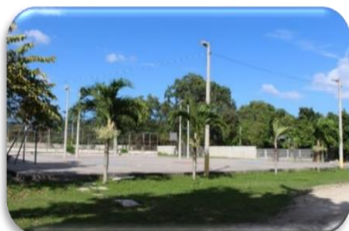
Instalaciones deportivas San Pedro Sula.
