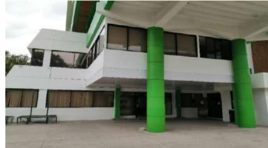
Edificio "B". (Campus Central UMH 2)
