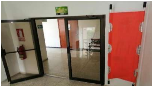
Salidas equipadas con camillas de emergencia. (Campus Central UMH 2)
