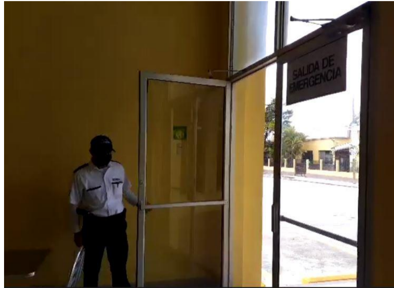
Foto de la Salida de Emergencia
