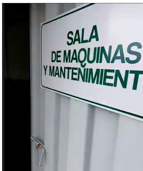
Foto de la Sala de Máquinas y Mantenimiento
