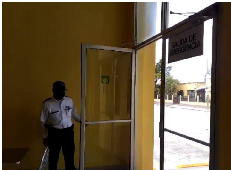
Foto de la Salida de Emergencia
