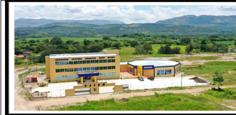
Instalaciones del Centro Regional de La Entrada, Copán
