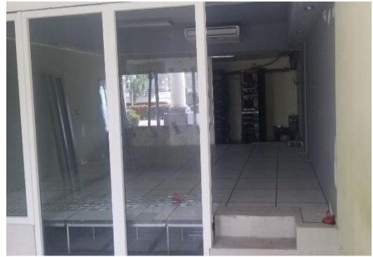
Data Center en Construcción
