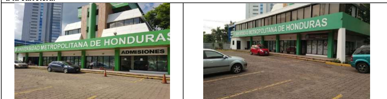
La ubicación del Consultorio Psicológico permitirá el fácil acceso al mismo, sin tener que ingresar a los bloques de aulas, estando el consultorio frente al portón de acceso a la carretera, lo cual cuidará la privacidad de los que lo visiten.
