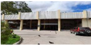
Acceso taller de mecánica automotriz, estacionamiento 3, contigua cancha de fútbol.
