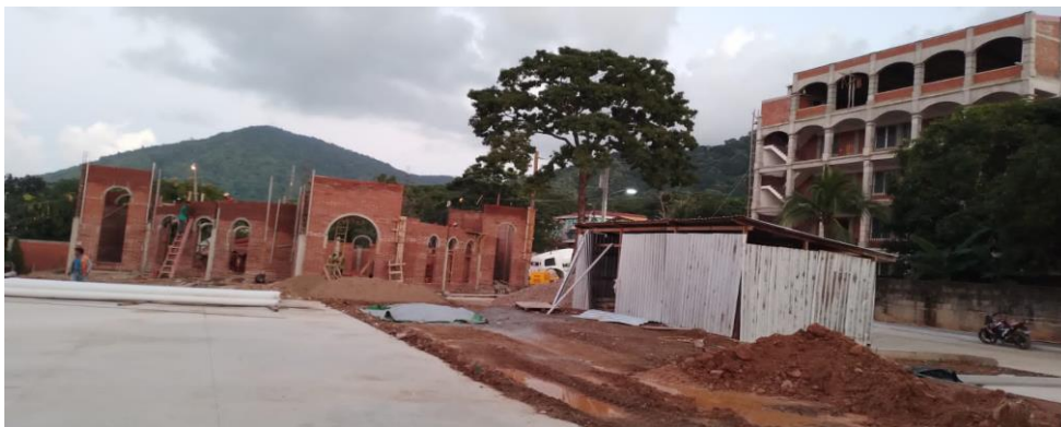
En proceso de construcción Capilla, Canchas y Parqueos
