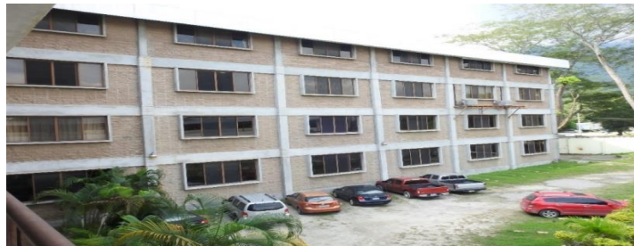
Edificio de la Universidad
