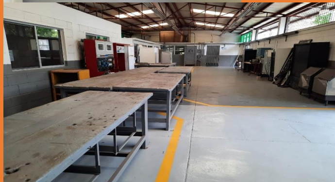
Equipo y aula taller de refrigeración y aire acondicionado
