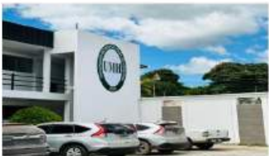
Fachada del Centro Regional
