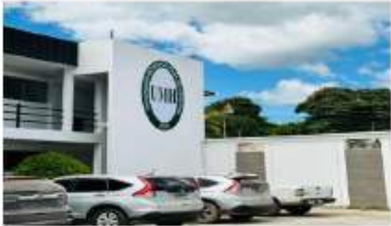
Fachada del Centro Regional
