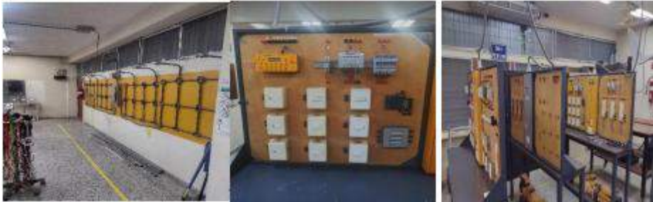
Área Maquinas Eléctricas AC y DC
