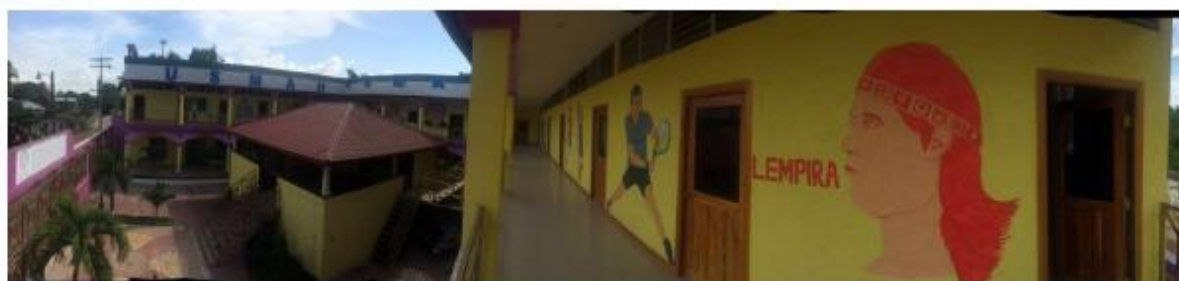
VISTA PANORÁMICA LATERAL DERECHO, SEGUNDO NIVEL AULAS DE CLASES
