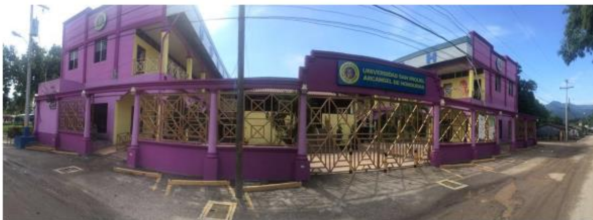
FACHADA FRONTAL Y AREA DE PARQUEO
